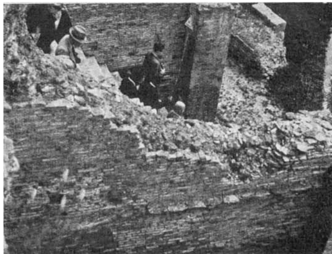
Abb. 3. Opus signinum: In eine Schalung aus Holz oder dünnwandigem Mauerwerk wurde normaler Grobmörtel, also Beton, eingeschüttet (Colosseum Rom).
